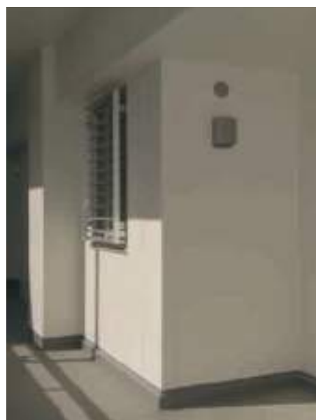
●一定範囲を自由に孔あけできるSLパネルの例。
