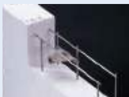
●工場埋設アンカー例
